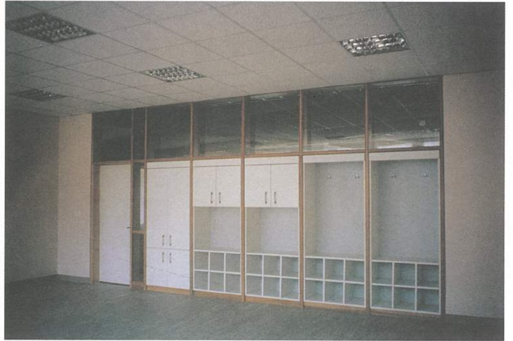
BİR İLKÖĞRETİM SINIFI DERSLİĞİNDE, KORIDOR DUVARI TÜMÜYLE MOBİLYA OLARAK KURGULANMIŞ. BÖLMENİN İÇ CEPHESİ, ÖĞRENCİ VE ÖĞRETMENİN KULLANIMINA AÇIK DOLAPLARDAN OLUŞUYOR. DIŞ CEPHE İSE PANO OLARAK KULLANILYOR. BÖLMENİN ÜST KESİMİ, İÇ BÖLÜMLERE IŞIĞIN GEÇMESİ İÇİN SAYDAM.
