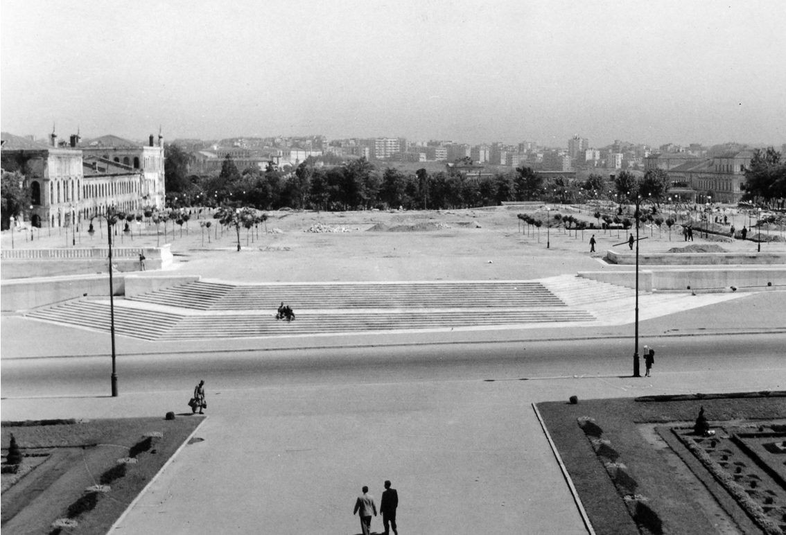
Figure 30: Demolition of the Taksim Barracks (İBB, Güzelleşen İstanbul)
