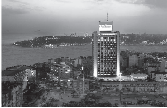
ETAP MARMARA OTELİ
